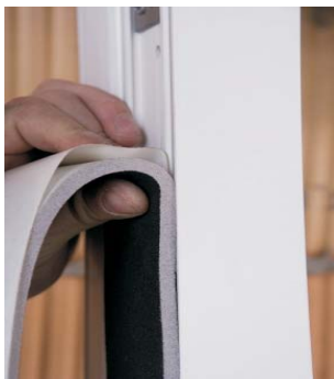
Joonis 2. Tihendi liimimine
