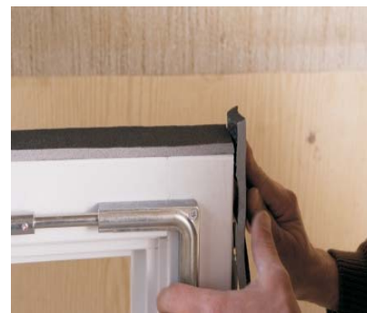
Joonis 3. Tihendi paigaldamine raami nurkades
