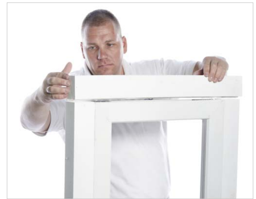
Raami eelkooste välimise paigaldamise puhul ("VAM")
